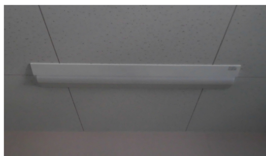
事務所及び通路でのLED照明設置
