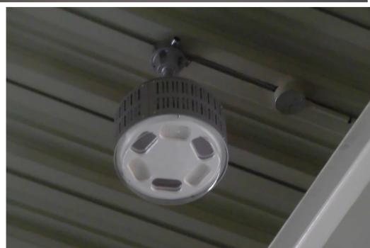
作業現場へのLED照明設置
